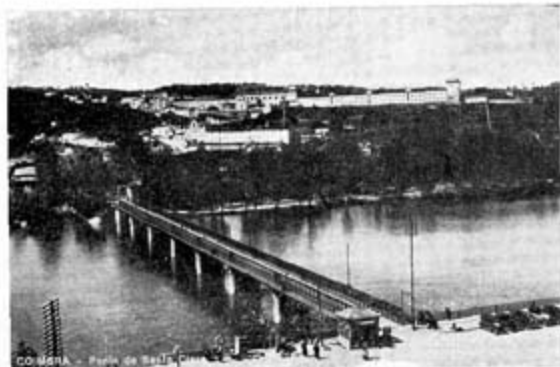
Puente de Santa Clara.
