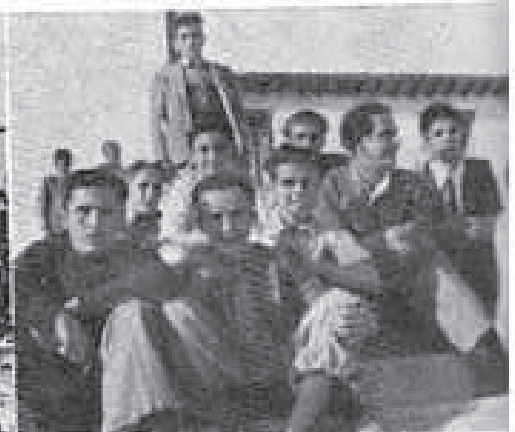
Después de ver la Central Eléctrica
