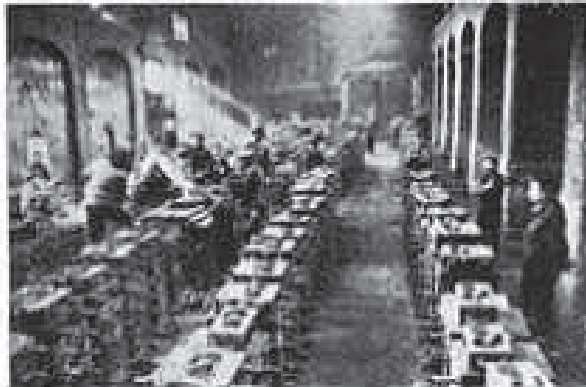
Sección de moldes de la fundición "Miguel de Prado"
