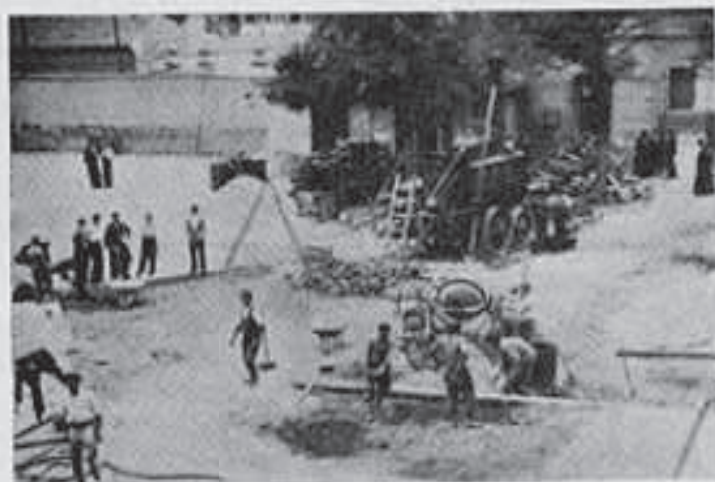
Un aspecto del patio del Colegio a punto de terminar su arreglo.
