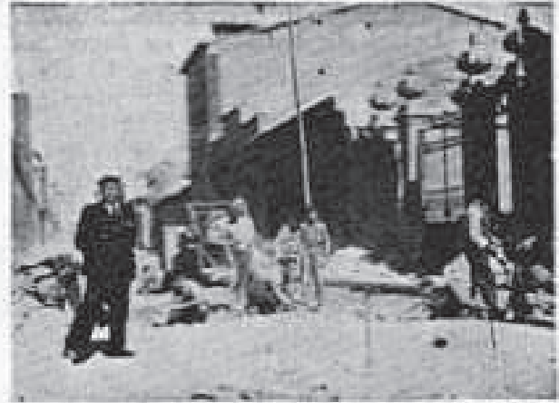
La calle cimentada la antevíspera de la entrada.
