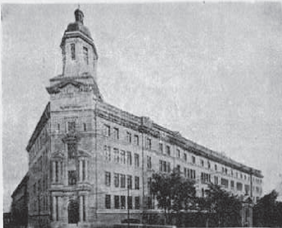
Vista general de la Academia Comercial de Québec (Canadá).
